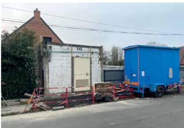
La première étape a consisté à sécuriser le poste, suivie de l'installation d'un transformateur de secours sur remorque, placé sur le trottoir. Après le terrassement du trottoir, un branchement souterrain a été réalisé pour relier le poste provisoire. Ensuite, le bâtiment actuel sera entièrement démoli afin de permettre la construction d'un nouveau local, prévue pour l'année 2025.
