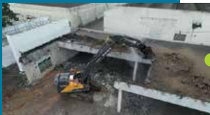
Le siège communautaire est la première pierre de la requalification du site AGFA. Parallèlement, le chantier de déconstruction a démarré en octobre jusqu'à l'été 2025. Au total, 13 bâtiments vont être déconstruits. Une plateforme de réemploi sera organisée ainsi qu'une unité de concassage afin de minimiser le transport de matériaux inertes et de favoriser le réemploi. Ces bâtiments sont déconstruits car ils sont trop vétustes, trop bas pour les futurs usages ou inappropriés au regard du projet.
